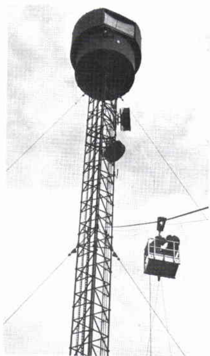
Kontroll av staglinorna gjordes förr med kikare från marken. Idag åker man bekvämt med stagklättraren.
